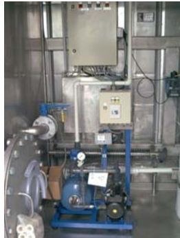
Druckerhöhungspumpe
