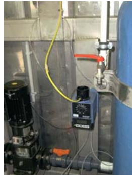
Spülpumpe, Dosierpumpe
