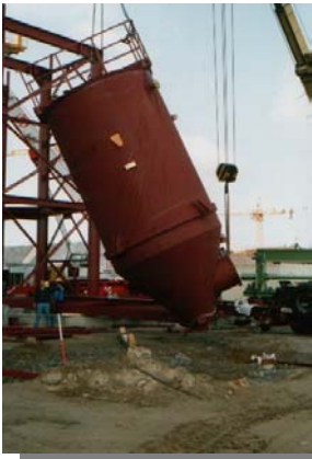
Aufrichten eines Behälters mit zwei Kränen
