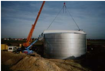
Montage einer Abdeckung
